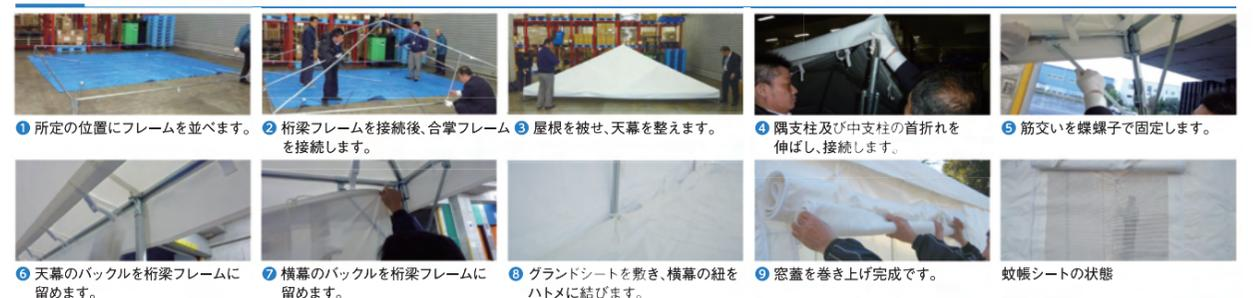
1 所定の位置にフレームを並べます。 2 桁梁フレームを接続後、合掌フレームを接続します。 3 屋根を被せ、天幕を整えます。 4 隅支柱及び中支柱の首折れを伸ばし、接続します。 5 筋交いを蝶螺子で固定します。 6 天幕のバックルを桁梁フレームに留めます。 7 横幕のバックルを桁梁フレームに留めます。 8 グランドシートを敷き、横幕の紐をハトメに結びます。 9 窓蓋を巻き上げ完成です。 蚊帳シートの状態
